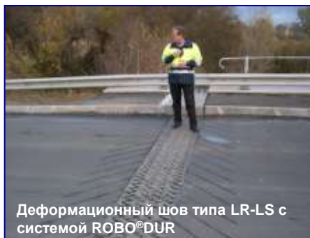
Деформационный шов типа RE-LS с системой ROBO®DUR
