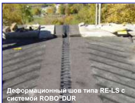
Желобки заполняются специальным раствором ROBO®DUR
